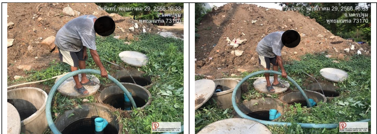
รูปที่ 2-18 การสูบน้ำจากตะกอนระบบบำบัดน้ำเสียของพื้นที่ก่อสร้างอาคารหอพักเจ้าหน้าที่ หลังที่ 2
