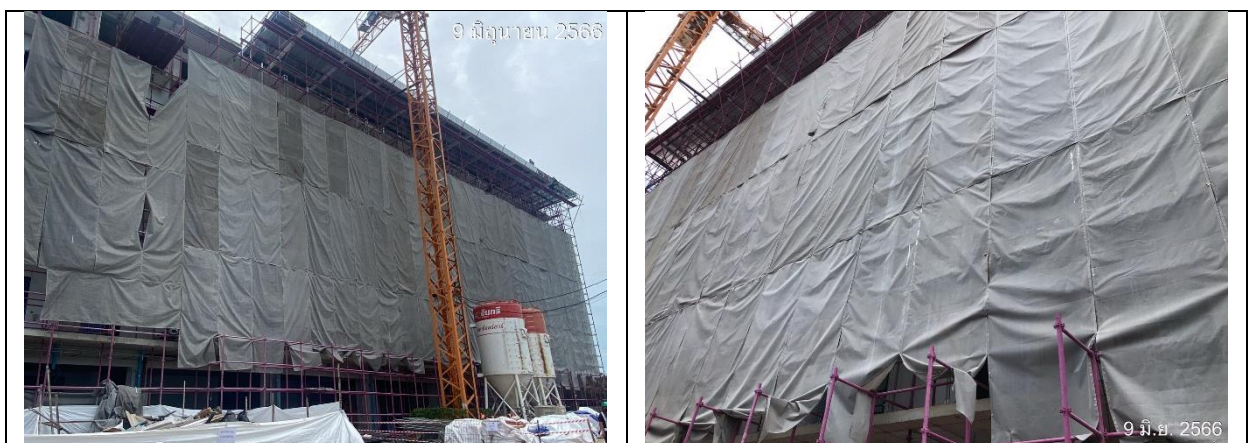
รูปที่ 2-7 การติดตั้ง Mesh Sheet โดยรอบอาคารหอพักเจ้าหน้าที่ หลังที่ 2
