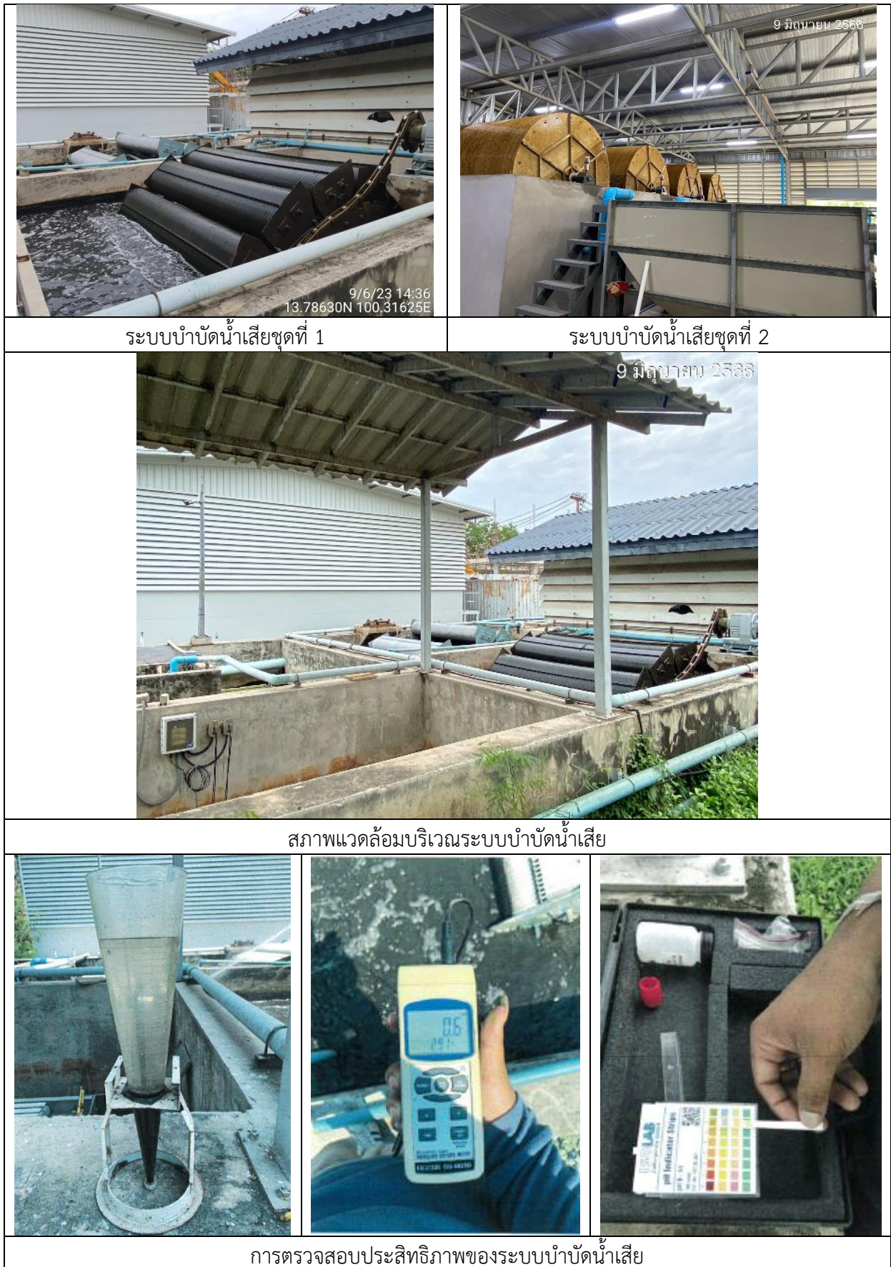
รูปที่ 2-41 สภาพปัจจุบันของระบบบำบัดน้ำเสียและการตรวจสอบดูแลระบบบำบัดน้ำเสียของโครงการ (ต่อ)
