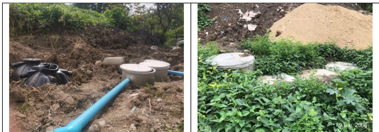
รูปที่ 2-17 ระบบบำบัดน้ำเสียของพื้นที่ก่อสร้างอาคารหอพักเจ้าหน้าที่ หลังที่ 2
