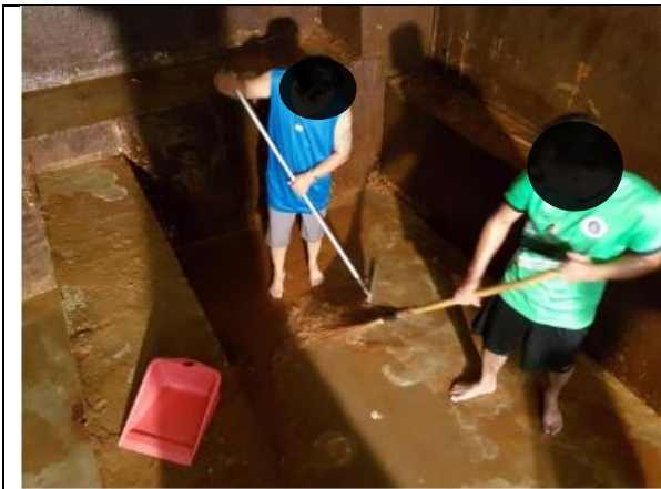
รูปที่ 2-48 การล้างถึงสร้างน้ำใช้ของโครงการ
