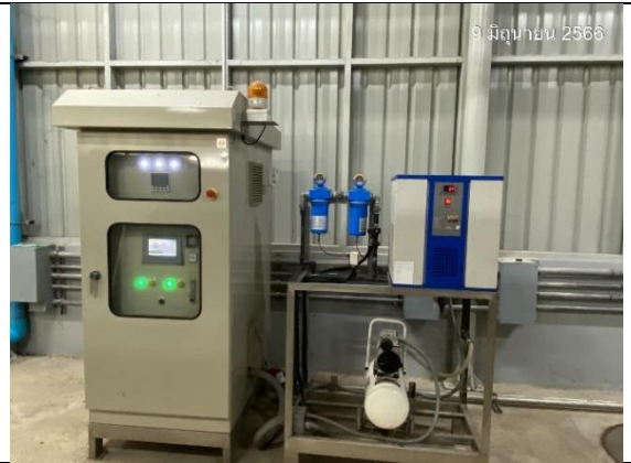
รูปที่ 2-50 การติดตั้งมิเตอร์ไฟฟ้าของระบบบำบัดน้ำเสียและการควบคุมการทำงานของระบบบำบัดน้ำเสีย
