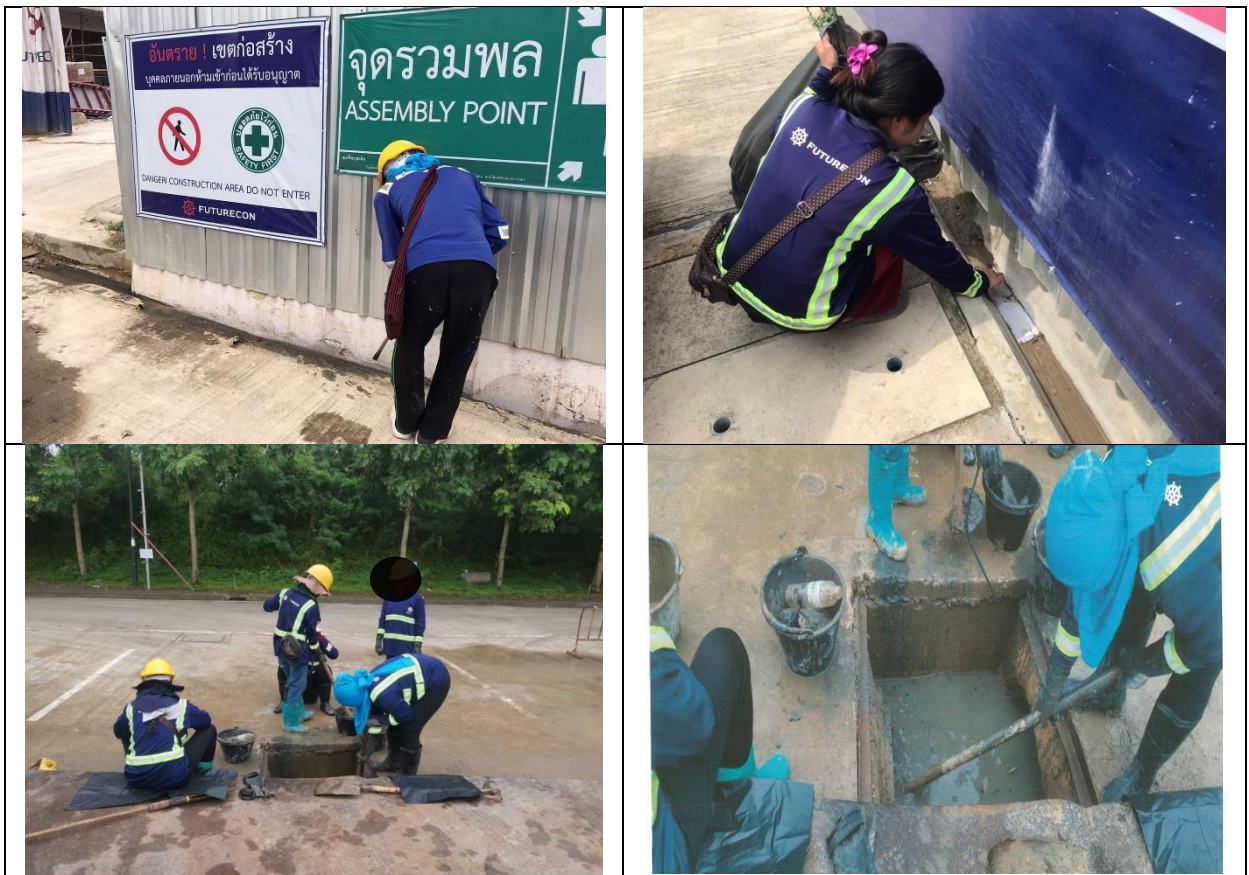
รูปที่ 2-20 การทำความสะอาดร่องระบายน้ำและการขุดลอกตะกอนดินในบ่อพักด้านหน้าพื้นที่ก่อสร้าง
