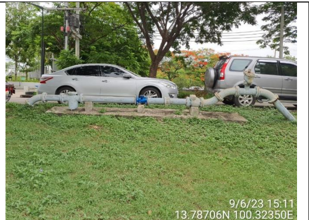
รูปที่ 2-45 การติดตั้งมิเตอร์น้ำประปาของโครงการ
