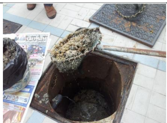
รูปที่ 2-51 การดูดกากไขมัน
