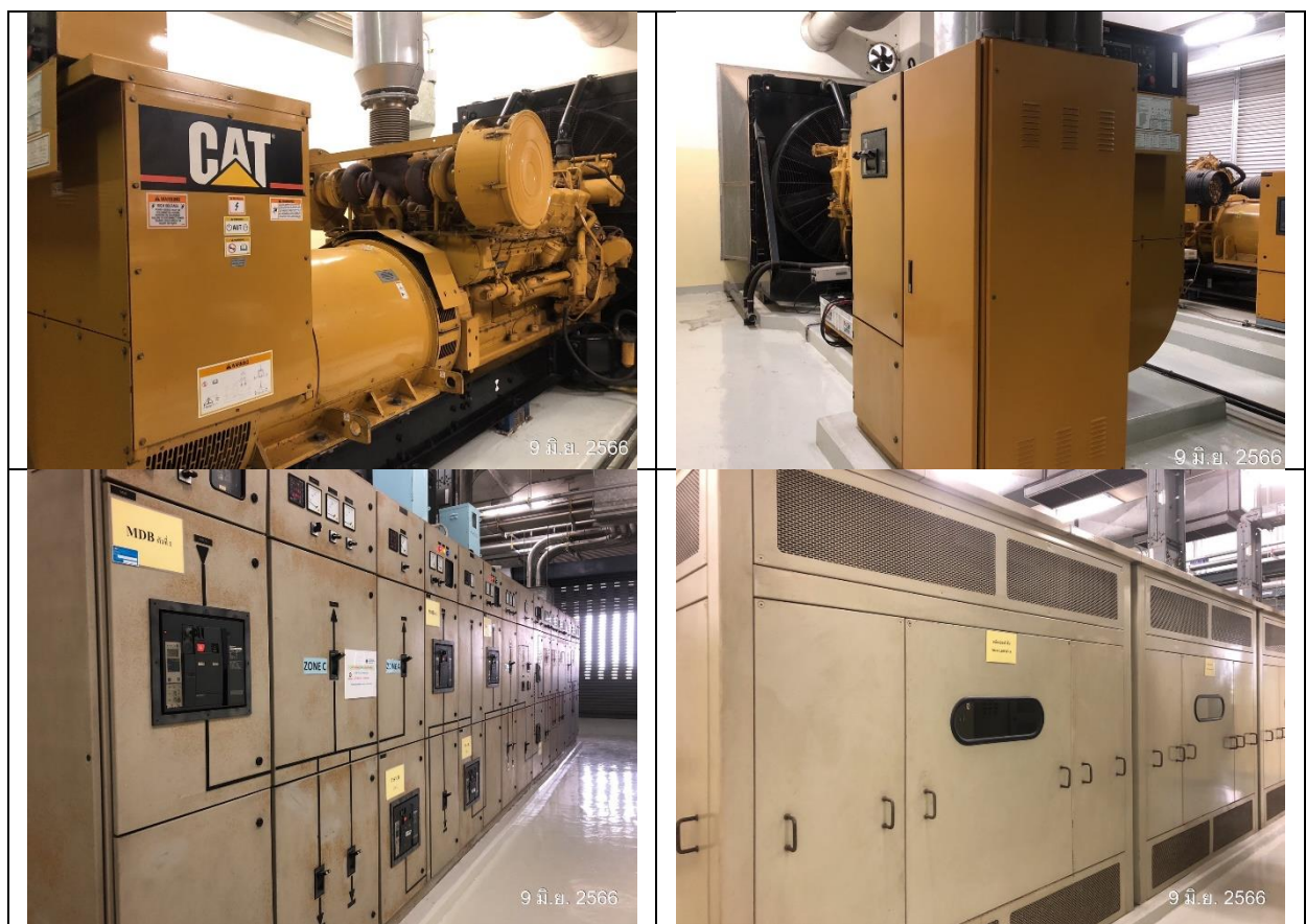
รูปที่ 2-55 การติดตั้งอุปกรณ์เกี่ยวกับระบบไฟฟ้า
