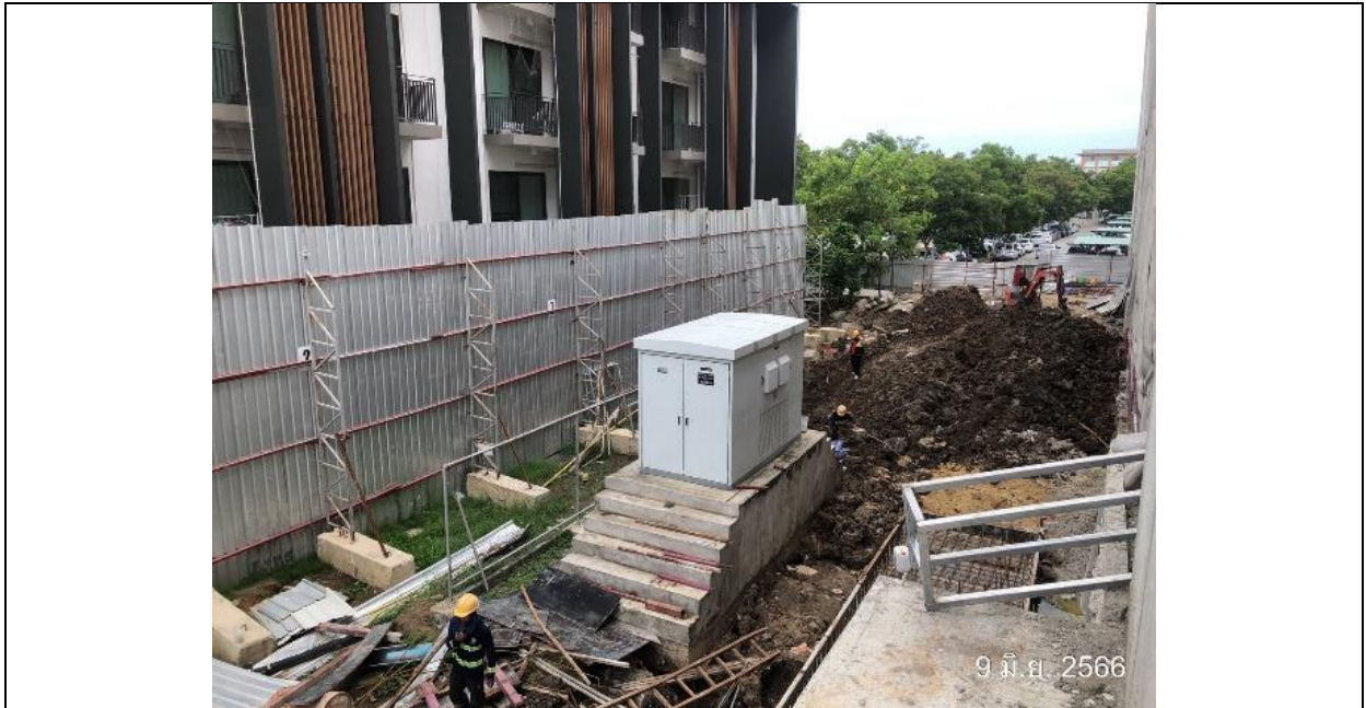
รูปที่ 2-12 ภาพการเปิดหน้าดินเพื่อติดตั้งระบบบำบัดน้ำเสีย
